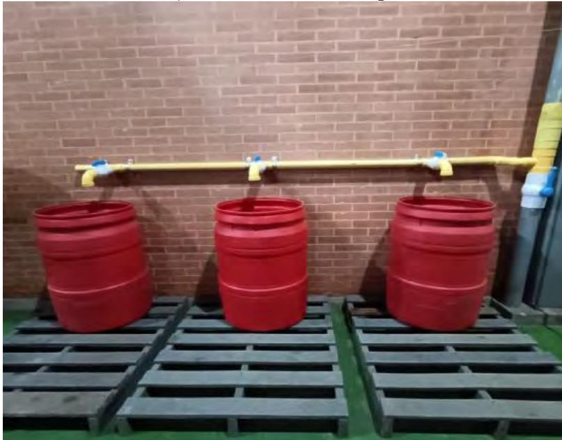
El sistema incorpora una conexión directa a la bajante pluvial, así como un sistema de derivación para evitar el llenado excesivo de los tanques de almacenamiento. Estos últimos, con una capacidad combinada de 208 litros.
